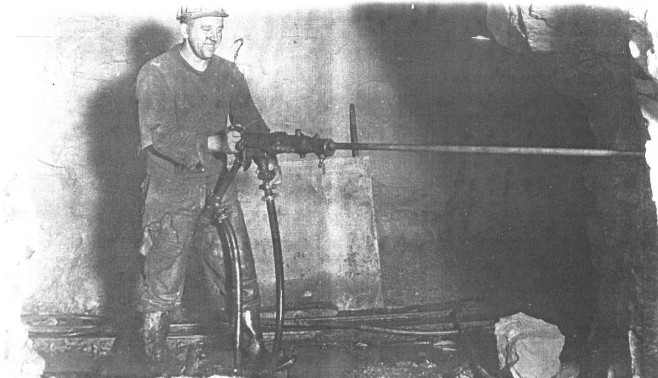
Vrtací pneumatické kladiv o při práci na přibírce chodby.
