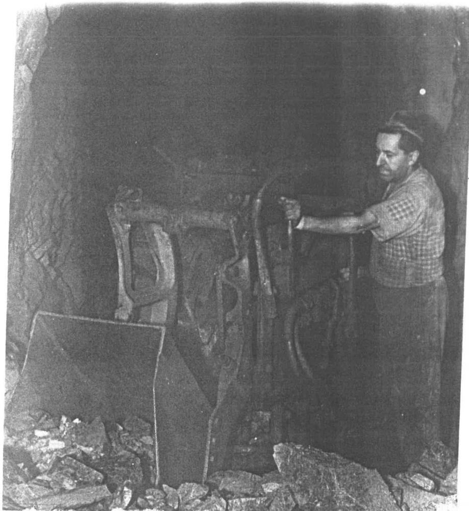
Dulní vzduchový nakladač při nakládání rubaniny na čelbě chodby.
