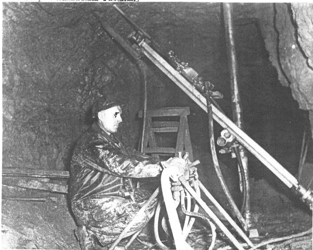
Sánové vrtací kladivo při vrtání na dobý- kových pracích na otevřené komoře.
